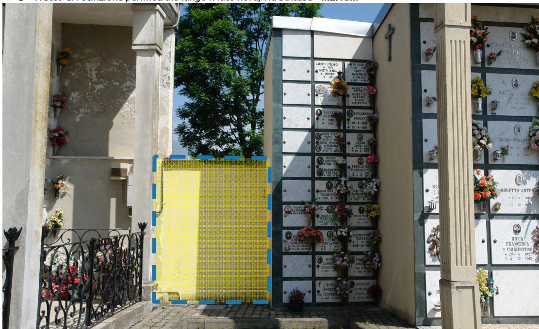
↓ 4 - Tratto di recinzione perimetrale lungo il lato Est - h.1.95m
