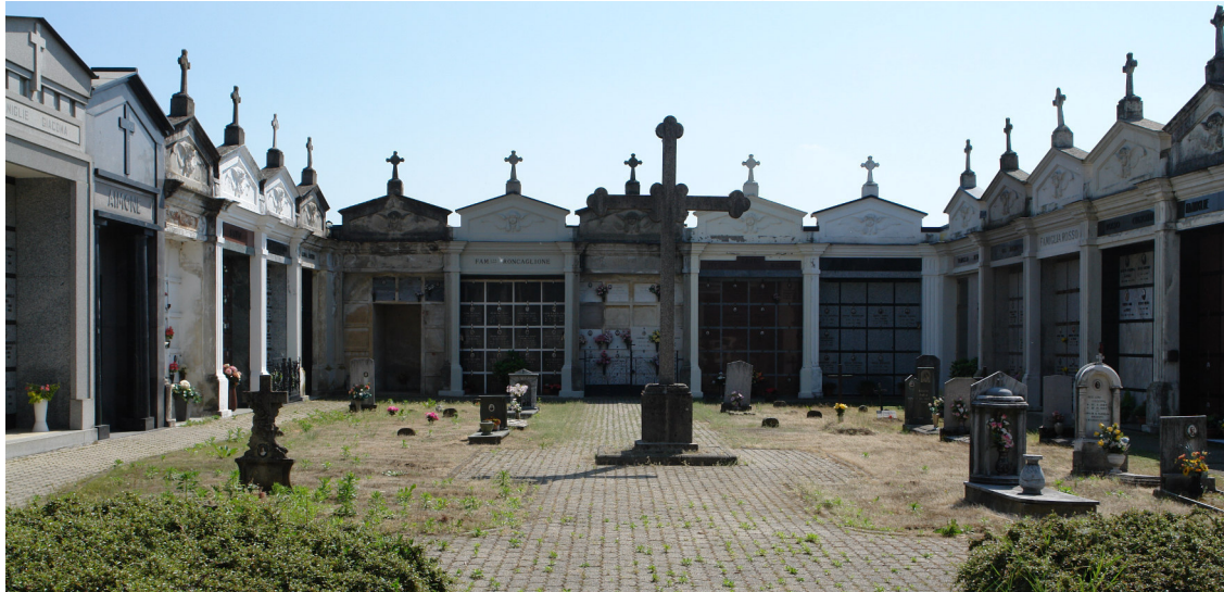
↓ Vista panoramica del cimitero: il nucleo storico originario
